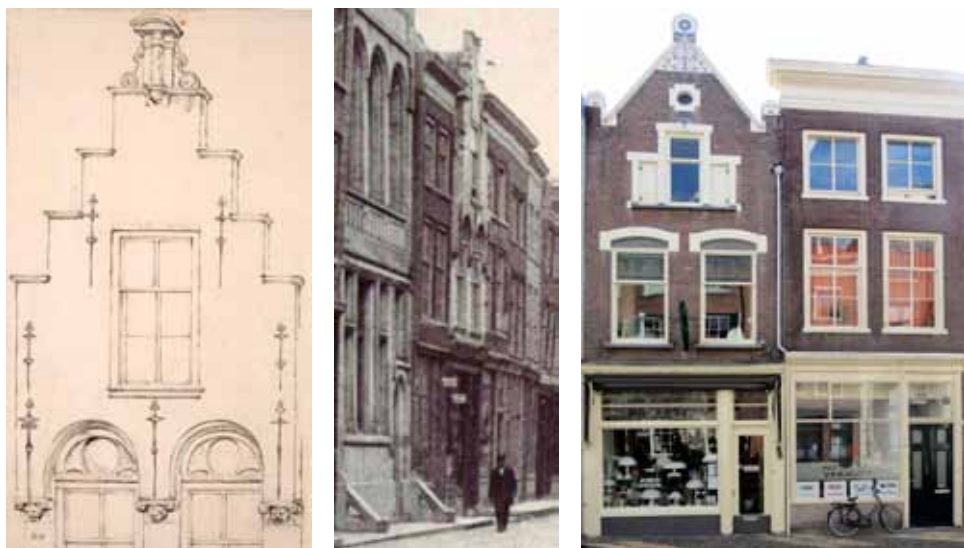
Links: het bovendeel van de gevel van Groenmarkt 14 (destijds wijk A nr. 10), getekend door Johannes Rutten rond 1870 (afb.: Beeldbank RAD 551-35857). Midden: de voorgevels van Groenmarkt 14 (de donkere onderpui met daarboven een 'Dordtse gevel') en Groenmarkt 16 zijn ter hoogte van de wandelende man zichtbaar op een prentbriefkaart uit 1904 (afb.: Beeldbank RAD 551-70392). Rechts: de voorgevels van Groenmarkt 14 en 16 in 2016 (foto: Kees Sigmond).
