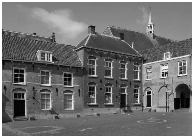
Op de plaats van het laatste restant van de zuidelijke kloostergang is het kerkkantoor gebouwd.
