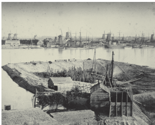
Gezicht op Dordrecht. In 1866 werd de fundering voor de spoorbrug gemaakt (GPV 551-55045).
