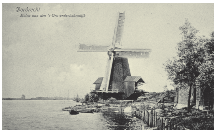
De Middelburg I, ook wel Stad Middelburg I genoemd, aan de 's-Gravendeelsedijk rond 1905 (GPV 551-71087).
