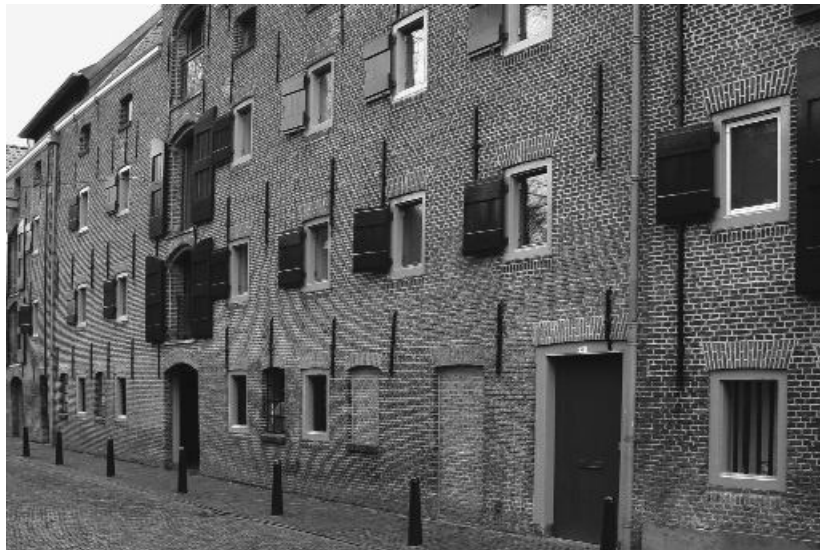
Achterzijde van de voormalige brouwerij Het Lam aan de Binnenwalevest.
