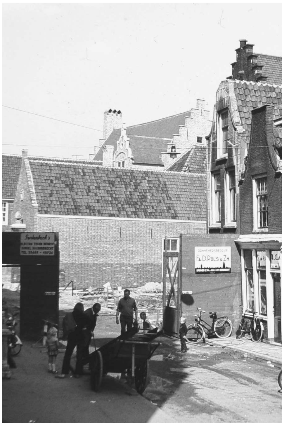
8.1 Werkzaamheden in de Hofstraat voor het inpassen van oude gevels uit het saneringsgebied.
