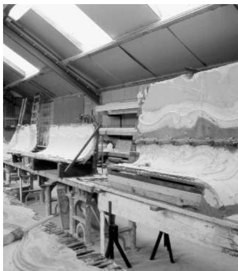
20.18 (links) In het atelier van Geerken in Zutphen worden de onderdelen van het stucplafond schoongemaakt.
