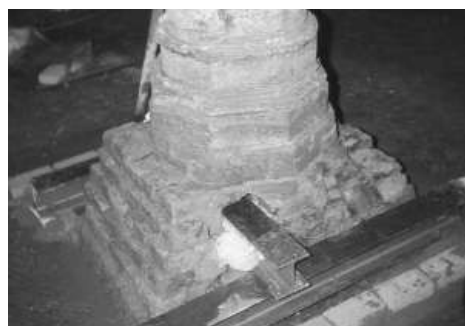
19.14 Na het harden van de krimpvrije mortel rond het profielstaal werd de procedure herhaald voor het tweede H-profiel.
