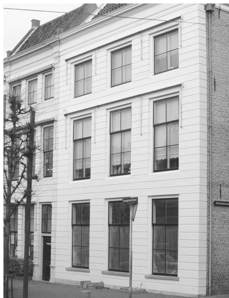
Pand Steegeversloot / hoek Schoolstraat.
