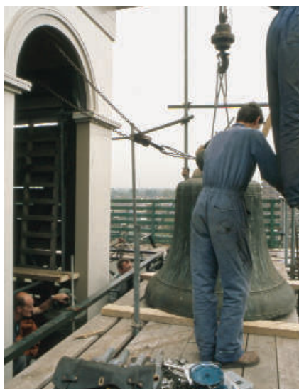
19.32 Het invoeren van de grote slagklok.
