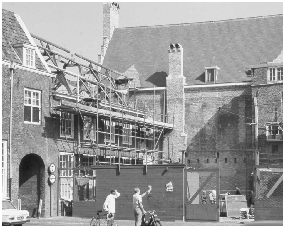
10.8 Restauratie van de zolderruimte aan de noordzijde met de vroeg-17e-eeuwse kapspanten.
