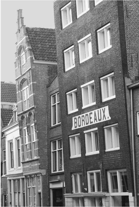
22.2 Links 'Het Henneke' met trapgevel (Wijnstraat 71/73), rechts het voormalige wijnpakhuis 'Bordeaux'. Doordat beide gebouwen op vlucht zijn gebouwd, lijkt het of het huis in het midden - dat te lood staat - achterover leunt.
