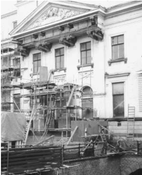
19.20 In drie fasen volgde het storten van de thans in gewapend beton uitgevoerde schachten.
