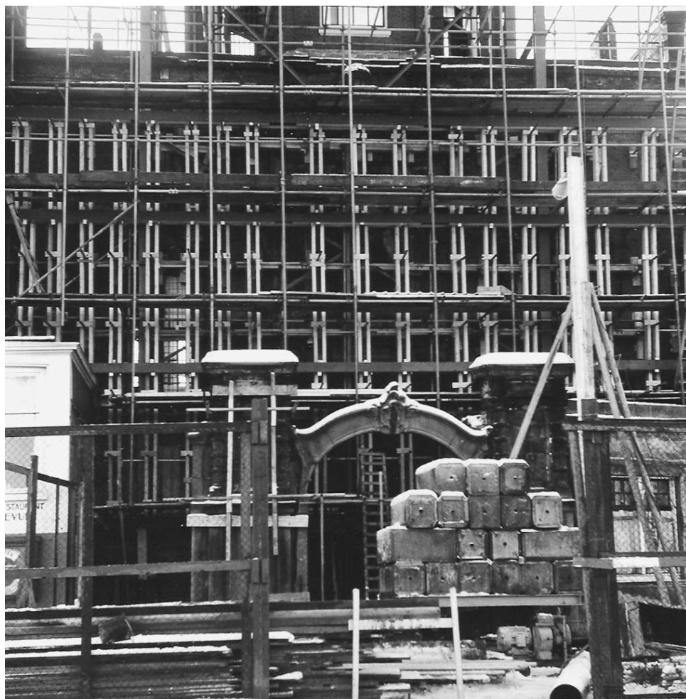
14.4 De rivierzijde van het poortgebouw dat aan beide kanten in een staalskelet was gezet. Schroefstempels en houten staanders ondersteunen het bouwwerk.
