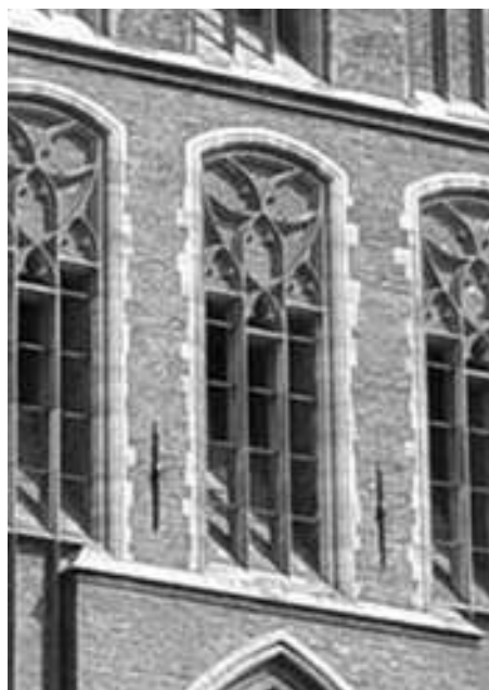
4.7 (rechts) De gereconstrueerde raamtracering aan de westzijde van de toren.
