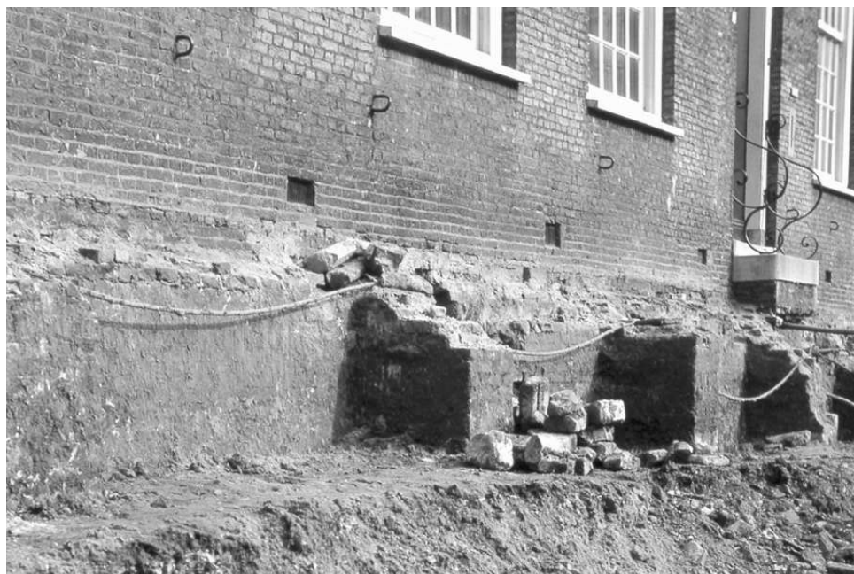
9.2 Bij de afgraving van het binnenplein kwamen delen van de steunberen van de voormalige kloostergang tevoorschijn.
