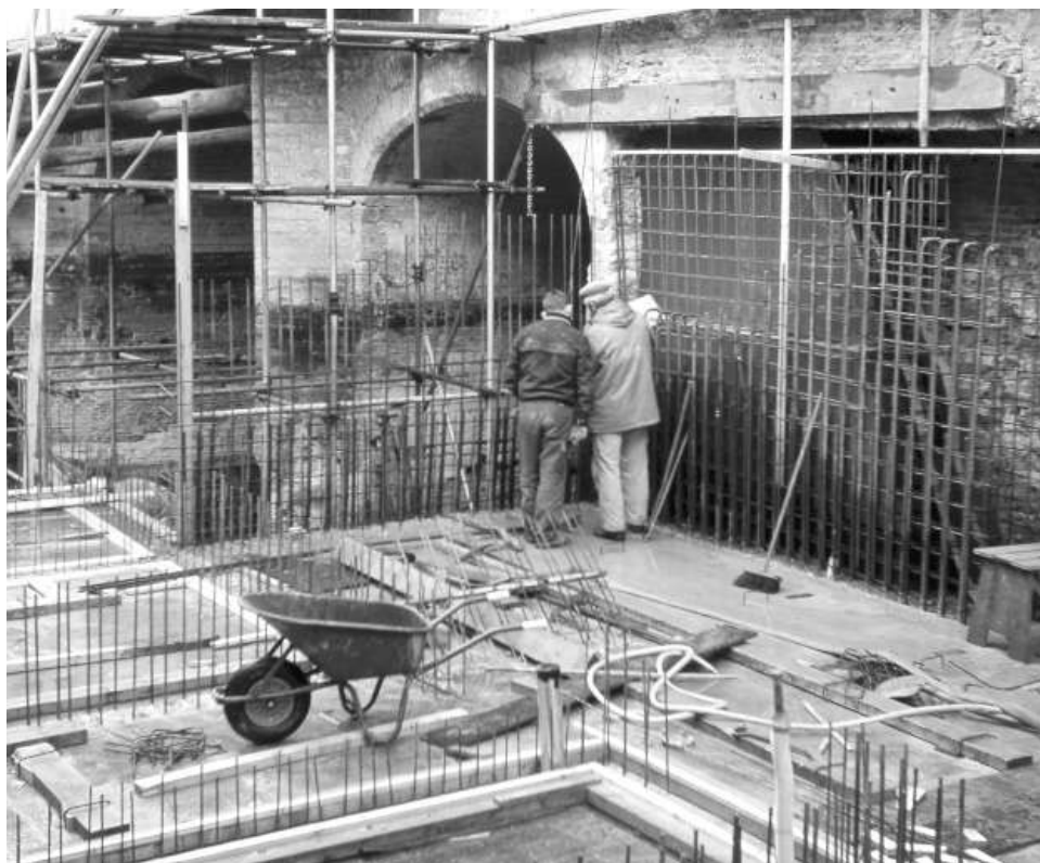
19.3 De wanden voor de doosvormige constructie onder de vleugel Groenmarkt in uitvoering.
