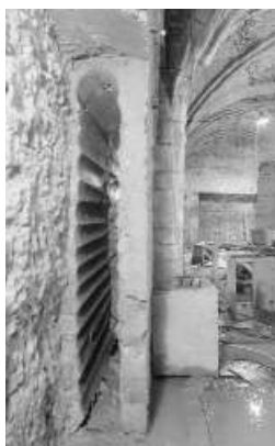
19.16 Uitboren van de spouwruimte t.b.v. waterkerende wandconstructie.
