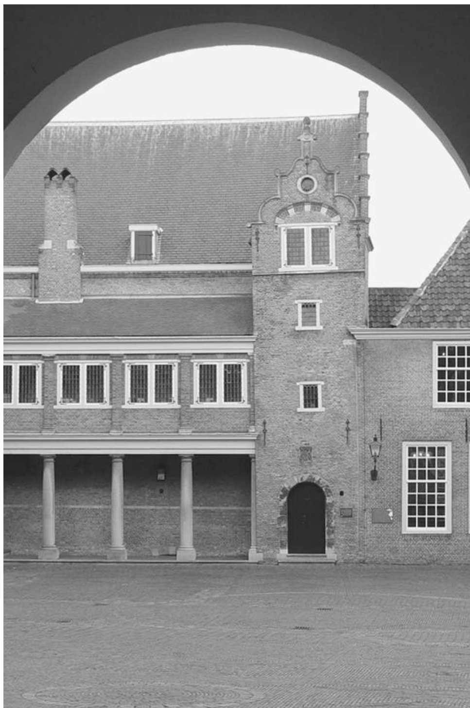
7.1 Het Hof, gezien in de richting van het gebouw van de Statenzaal.
