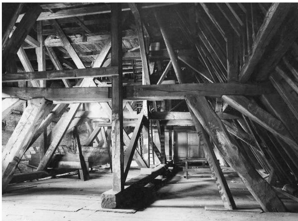
16.4 Aangetroffen staketsels in de kapverdieping ter ondersteuning van de toren.
