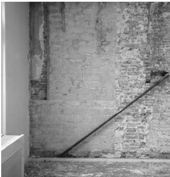
17.3 Zichtbaar is de bouwnaad als aanduiding voor de plaats van de achtervleugel Groenmarkt tot 1830. Links de raamkant van een van de kloosterkozijnen op de verdieping van de huidige Raadzaal.
