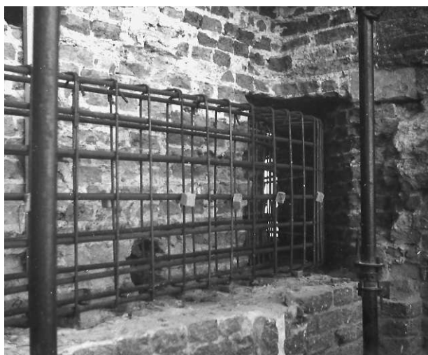
4.4 Het aanbrengen van een gewapend-betonnen ringbalk ter hoogte van de uurwerkzolder.
