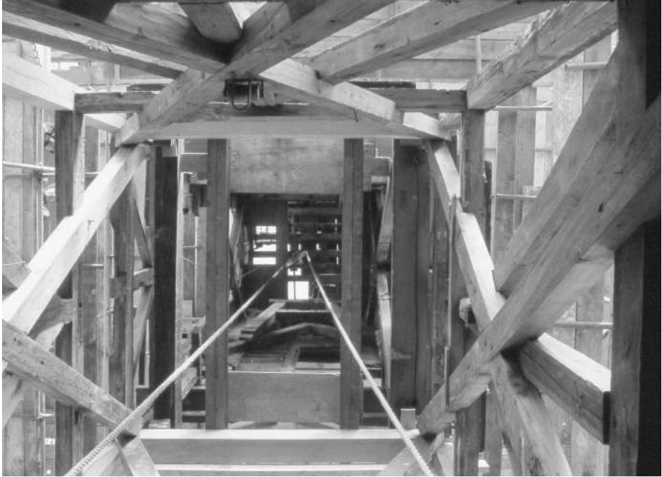
19.31 De toren van onder naar boven met een veelheid aan schoren.
