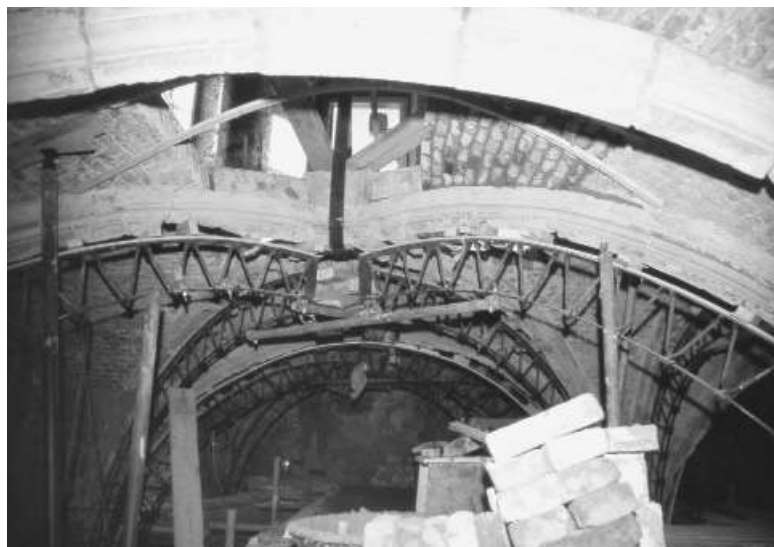
19.4 Ribdelen en de twee sluitstenen worden vervangen. Daartoe moesten allereerst de stalen formen worden opgesteld.
