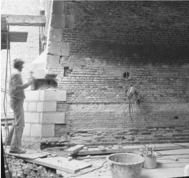
19.9 Voorzieningen aan de onderbouw van de Lombardbrug.
