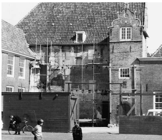
9.14 Restauratiewerkzaamheden aan de voorgevel van het Statengebouw.
