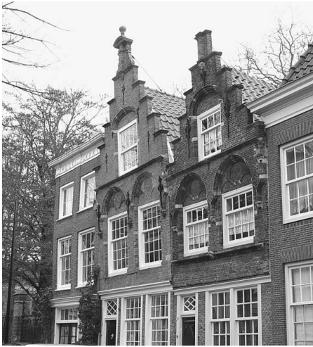
22.4 Architect Van den Berg plaatste de 'Dordtse gevels' in de Museumstraat 'op vlucht'.
