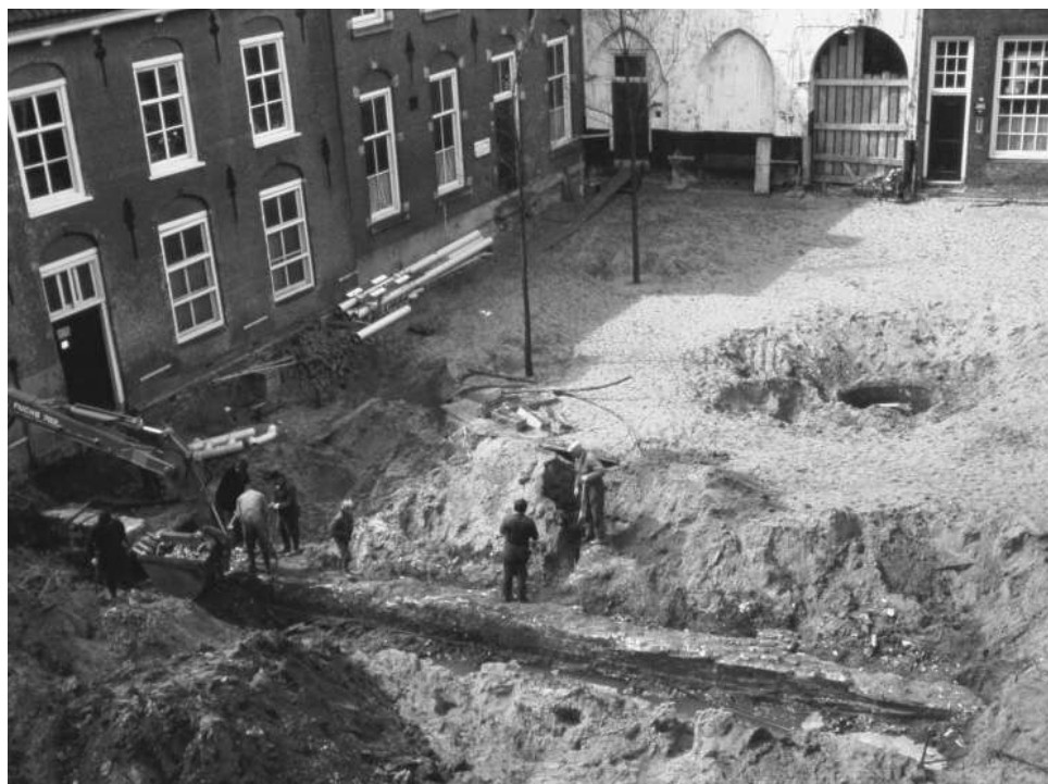
10.2 De opgraving van de fundering van de kloostergang en de waterput.
