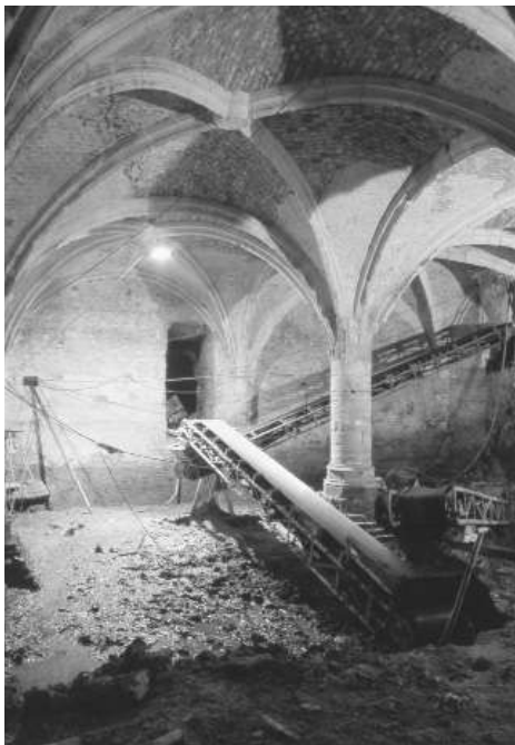
19.10 Het verwijderen van de bakstenen vlijlaag en de verdere ontgraving tot aan de onderkant van de werkvloer in het onderhuis.
