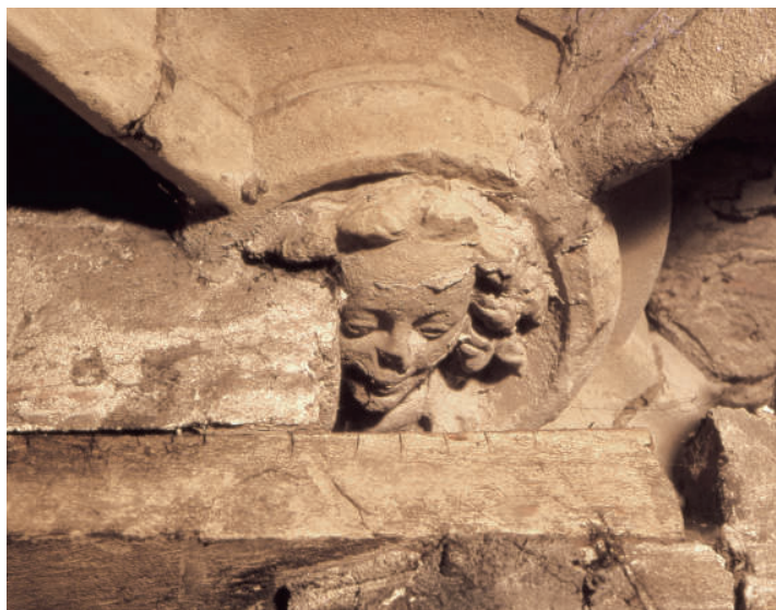
16.3 In het onderhuis werden slechts enkele weinig-beschadigde sluitstenen aangetroffen. Er zouden twee nieuwe sluitstenen moeten worden gemaakt.
