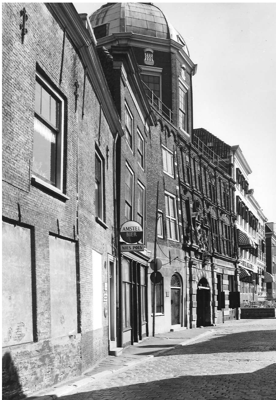
14.1 Het gebouw van de Groothoofdspoorst bood aan de kant van de Wijnstraat (de landzijde) een verwrongen aanzien. Er was sprake van een geplooid gevel. De bouwtechnische staat verslechterde zienderogen.
