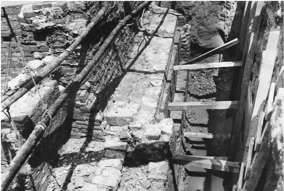
18.9 De fundering van de vleugel Voorstraat, resten van het Cipiers Huys. Foto van H. Boshoven, gemaakt vanaf de kant van de Lombardbrug.
