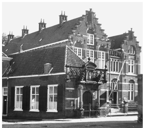
8.3 (rechts) Het in verband met de sanering afgebroken schoolgebouw in de Hofstraat.
