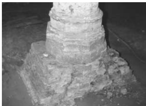
19.12 De kolomfundatie is weggehakt.
