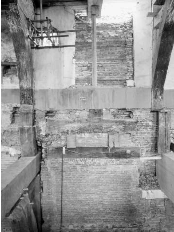
19.24 Opname in de eerste travee boven de Schepenkamer. In de achtergevel een zware eiken lateibalk die medio 1688 boven de opening van het kruiskozijn werd geplaatst. Verder de balkkoppen van de nu afgezaagde grenenhouten balklaag uit 1688.
