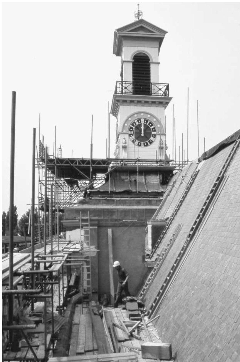
21.1 De torenafwerking in de eindfase.
