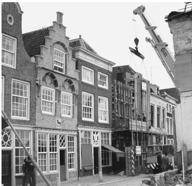
11.5 Het herplaatsen van een gevel in de Nieuwstraat.
