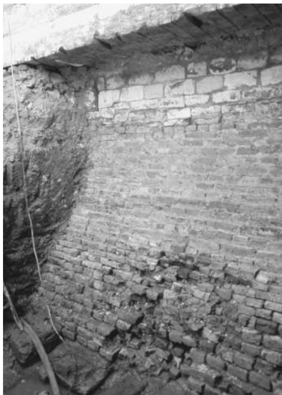
18.3 Onderzoek van de fundering van de middeleeuwse beuk aan de pleinkant. Boven in beeld de door Itz aangebrachte voorgevelbekleding tegen de oorspronkelijke natuurstenen voorgevel.
