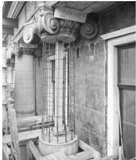
19.20 In drie fasen volgde het storten van de thans in gewapend beton uitgevoerde schachten.
