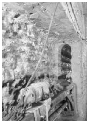
19.16 Uitboren van de spouwruimte t.b.v. waterkerende wandconstructie.
