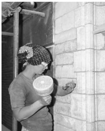
19.25 Ter aanvulling van kantstijlen, waterlijsten e.d. werd hier Franse kalksteen verwerkt.
