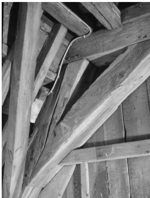
16.5 (links) Detail van de middeleeuwse kapconstructie.
