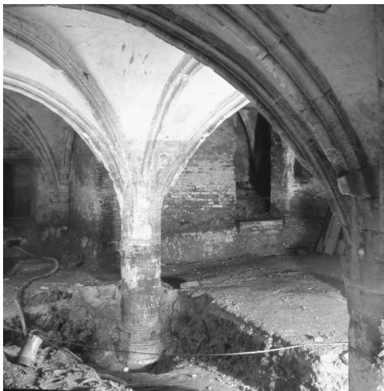
18.2 Ontgraving in het onderhuis tot op het vroegste vloerniveau. Gezicht op de dichtgemetselde oorspronkelijke doorgangen van het onderhuis naar de vleugel Groenmarkt.
