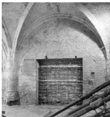
19.16 Uitboren van de spouwruimte t.b.v. waterkerende wandconstructie.
