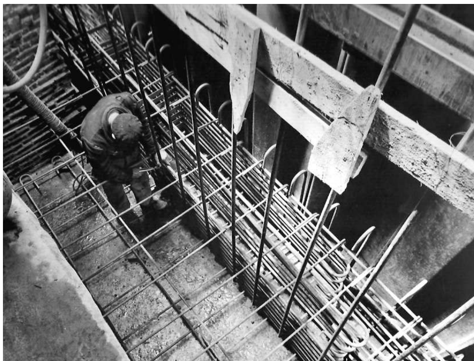
3.6 Vlechten van de wapening t.b.v. de verstijvingsring die om de voet van de oude fundering wordt gelegd.
