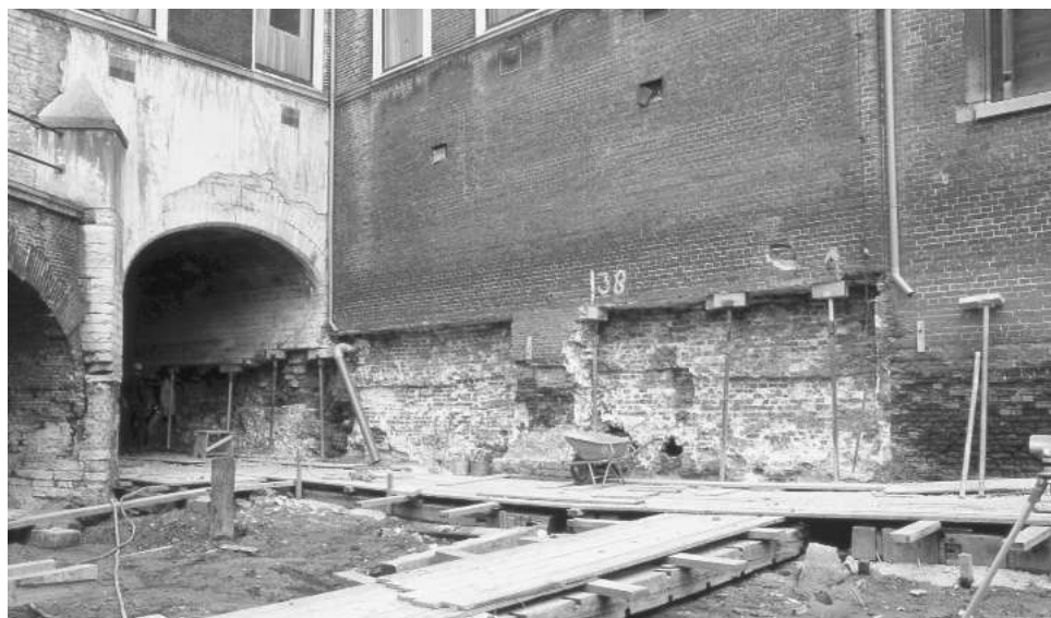
19.7 Voorzieningen aan de havenzijde, onderbouw vleugel Voorstraat.
