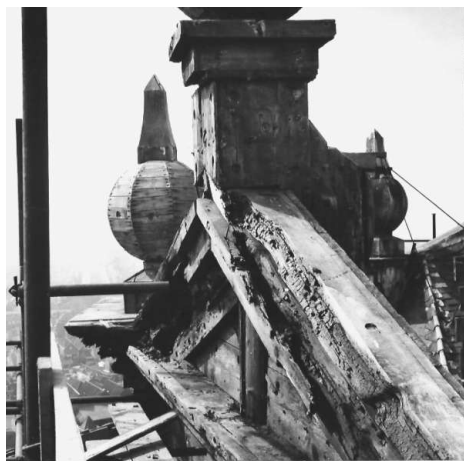
4.9 (links) Bij het verwijderen van de loden bekleding van de timpaanvormige bekroning boven de wijzerplaten bleek het houtwerk nodig aan herstel toe.
