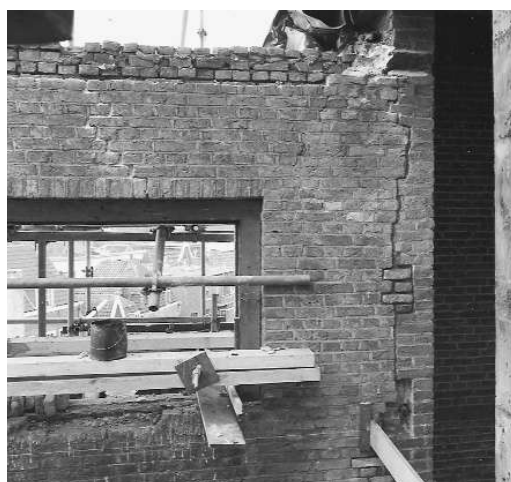
19.30 De aanhechting in het metselwerk na de doorbreking van de eerder doorgaande vlakke attiek.
