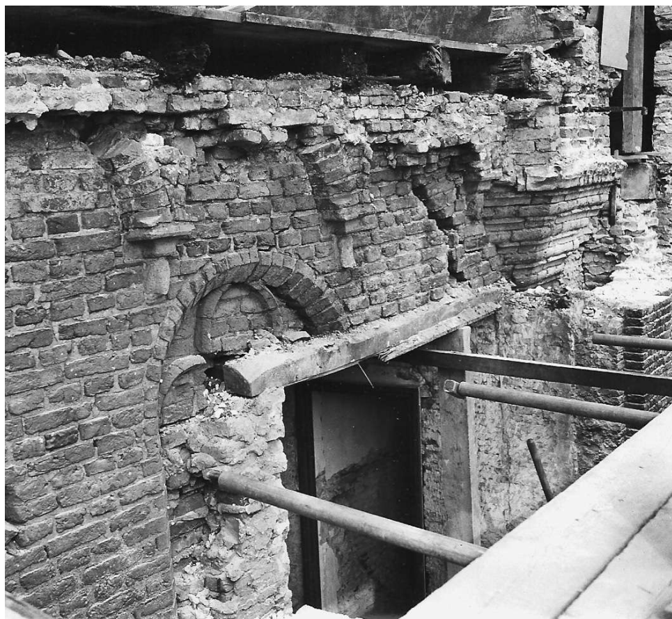
14.10 Aan de landzijde van de Groothoofdspoor is een gedeelte van het middeleeuwse uiterlijk zichtbaar achter de gevel uit 1618.
