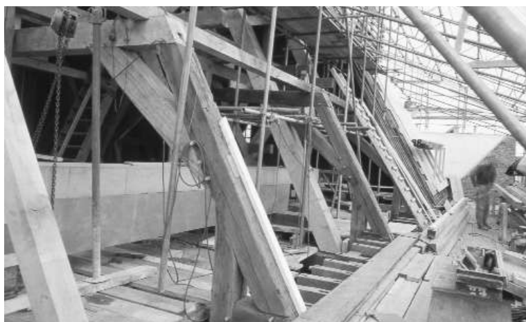
19.28 Herstel en versterking van de middeleeuwse kaspanten ter plaatse van de toren. Door toevoeging van een naar binnen geplaatste kreuple stijl wordt de belasting van het torengewicht naar de achtergevel afgeleid.
