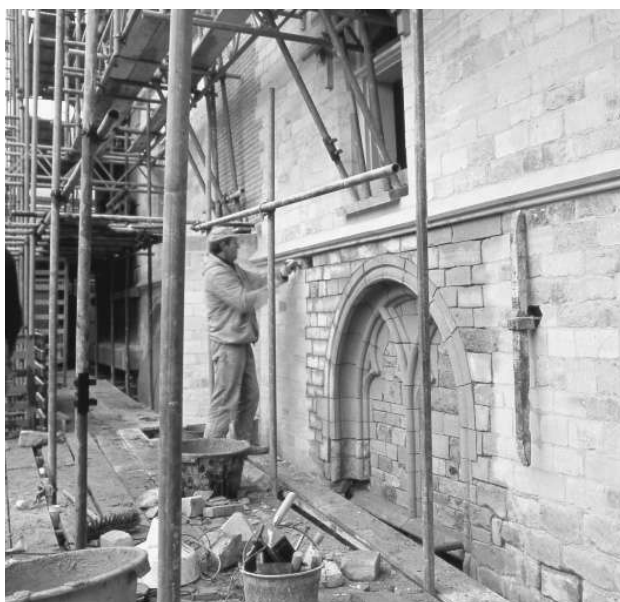
19.27 Herstel van de middeleeuwse achtergevel en gaanderij uit 1544.
