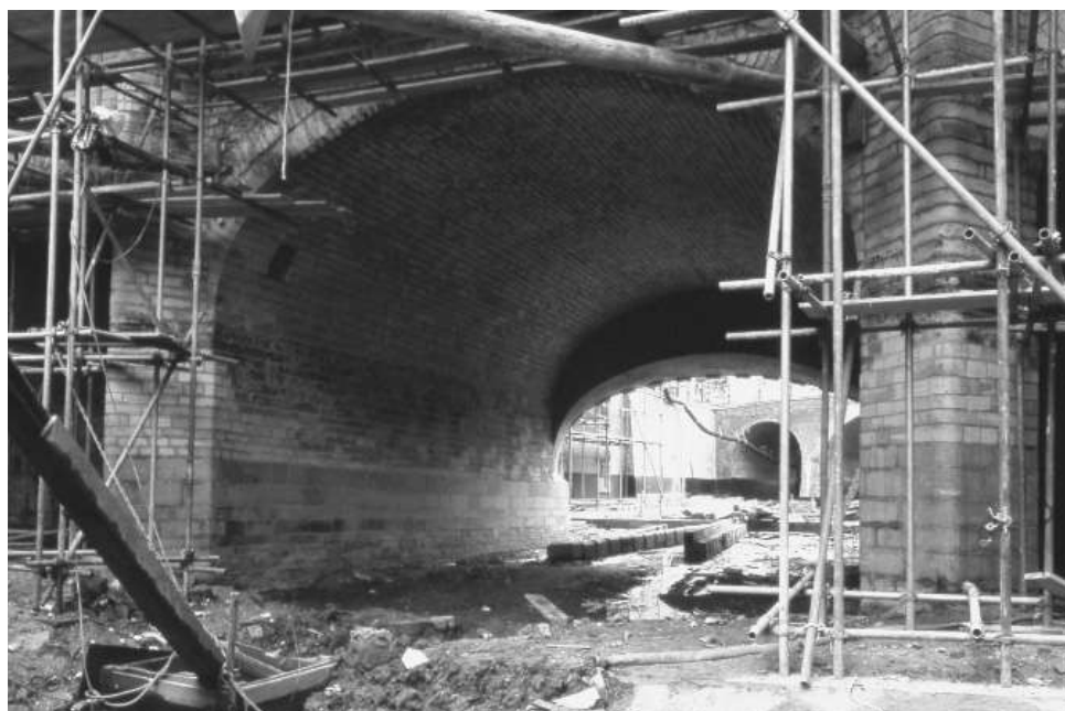
19.8 De havenwerken zijn gereed voor het inlaten van het buitenwater ter controle op de waterdichtheid van de constructies.
