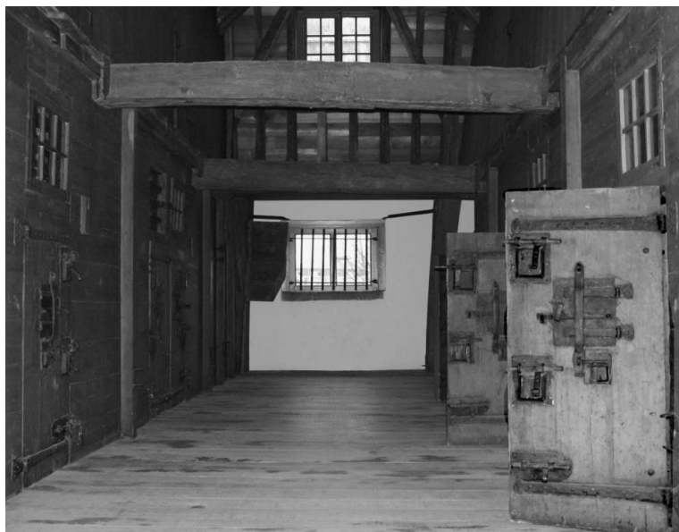
20.30 De celruimte na de restauratie (2005).
