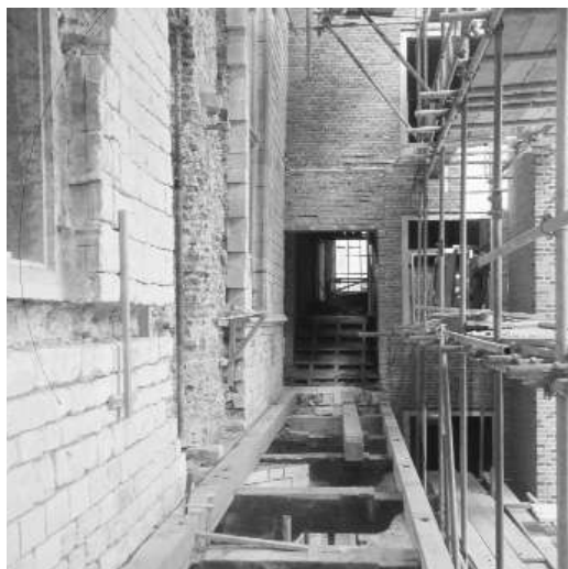
19.25 Ter aanvulling van kantstijlen, waterlijsten e.d. werd hier Franse kalksteen verwerkt.
