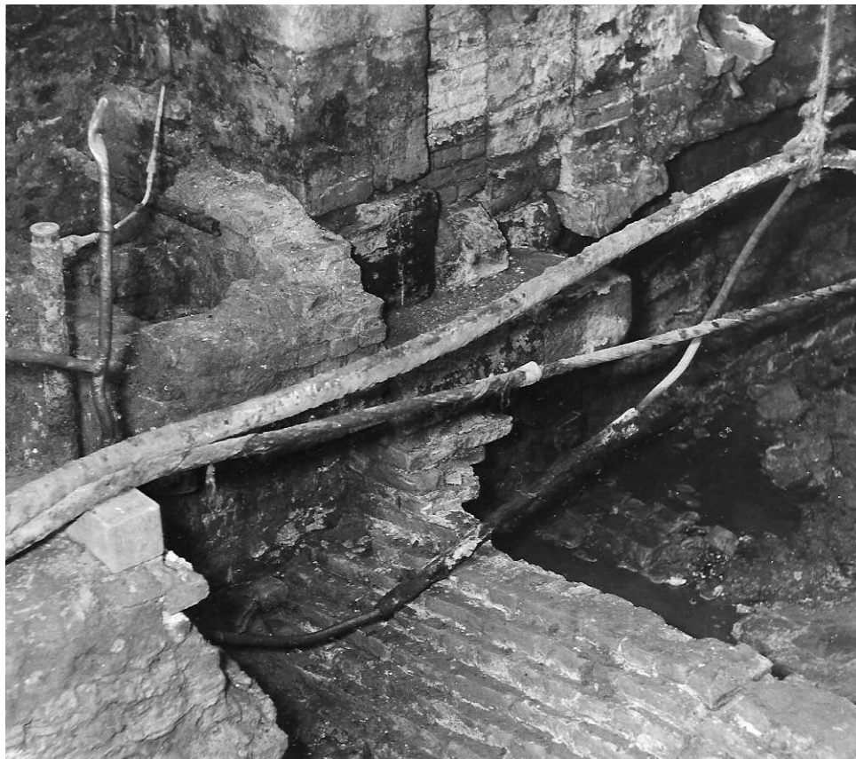
13.3 De fundering van de Groothoofdspoot zoals die bij het onderzoek werd aangetroffen.
