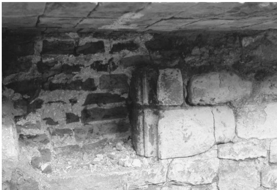
17.7 Bij het onderzoeken van de fundering werd aan de Halsteiger (nu pleinzijde) een fragment van een oorspronkelijke lichtopening aangetroffen. Deze was door Itz dichtgemetseld.
