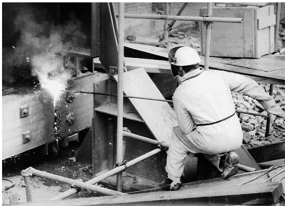
14.8 Het gebruik van de thermische lans zorgde ook voor spectaculaire beelden.
