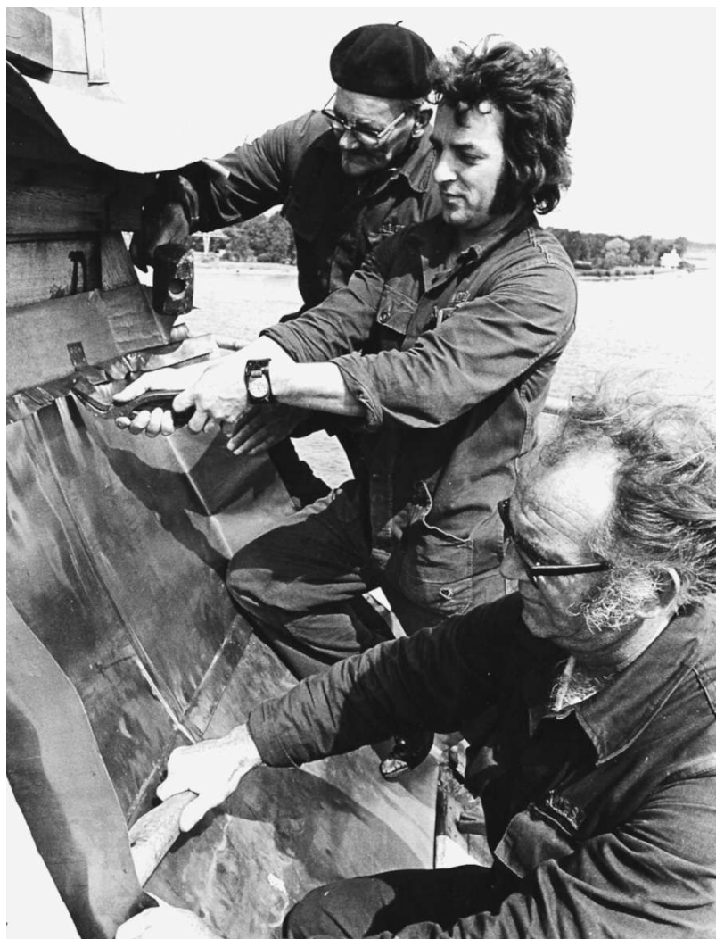
14.16 Uiteindelijk werd gekozen voor een koepelbekleding van koper en voor het bovenste gedeelte (de lantaarn) van lood. Daarmee werd recht gedaan aan het bestek uit de jaren negentig van de 17e eeuw. Werknemers van de firma Jobse uit Middelburg brachten de nieuwe bekleding aan.
