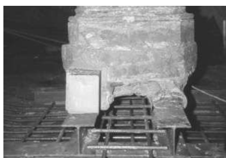
19.14 Na het harden van de krimpvrije mortel rond het profielstaal werd de procedure herhaald voor het tweede H-profiel.
