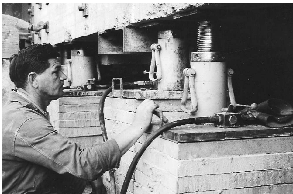
14.9 Het vijzelen gebeurde in fases van twee tegels hoog (= 12 cm). De verbinding tussen de tegels gebeurde met snelverhardende cement (Cebat). De totale hoogte die aan de landzijde moest worden overbrugd met vijzelen, bedroeg 95 cm.
