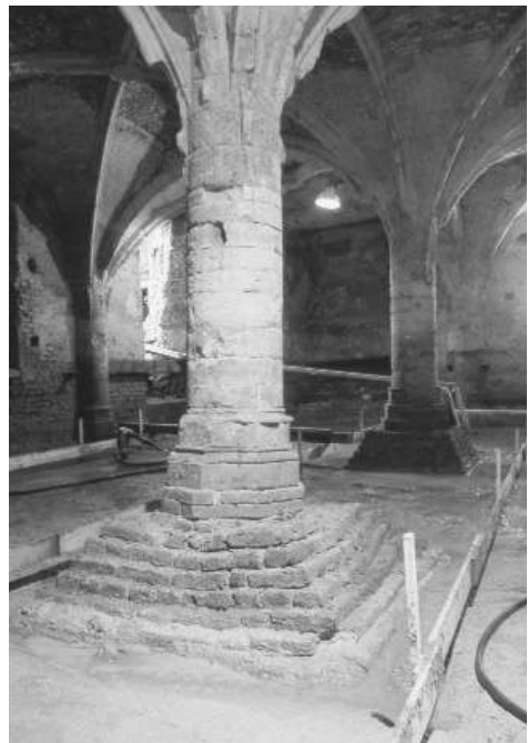
19.10 Het verwijderen van de bakstenen vlijlaag en de verdere ontgraving tot aan de onderkant van de werkvloer in het onderhuis.
