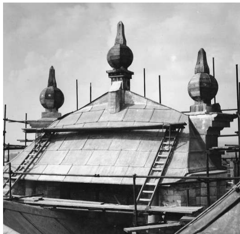
4.9 (links) Bij het verwijderen van de loden bekleding van de timpaanvormige bekroning boven de wijzerplaten bleek het houtwerk nodig aan herstel toe.
