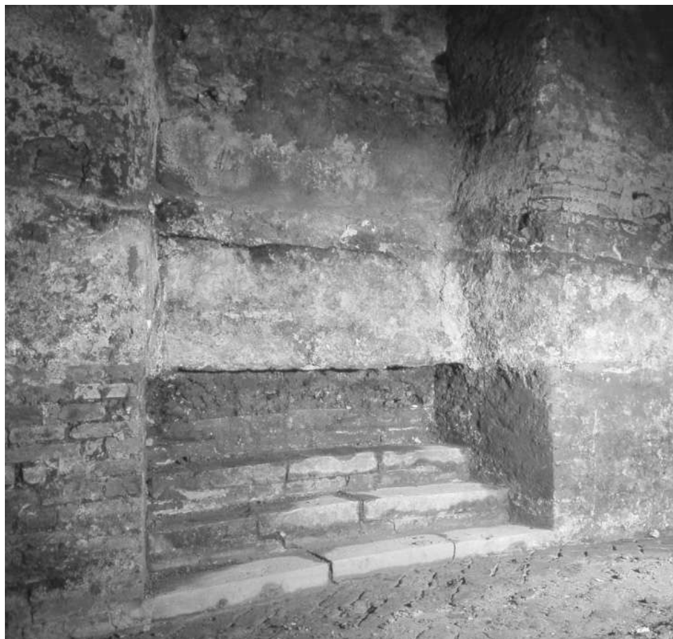
18.6 De oorspronkelijke toegangen tot het onderhuis bevonden zich aan de Groenmarkt. Vanuit het onderhuis waren enkele treden voldoende om het toenmalige kleine hoogteverschil naar de openbare weg te overbruggen.
