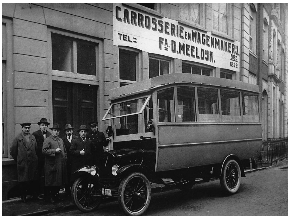
Afb. 4.3 De Dordtse carrosseriebouwer Fa. D. Meeldijk in de Grotekerksbuurt leverde omstreeks 1922 een buscarrosserie af op een Ford-chassis mogelijk bestemd voor de eerste Dordtse stadslijn van de E.D.A. van Bongers, (fotocollectie W. Geense).
