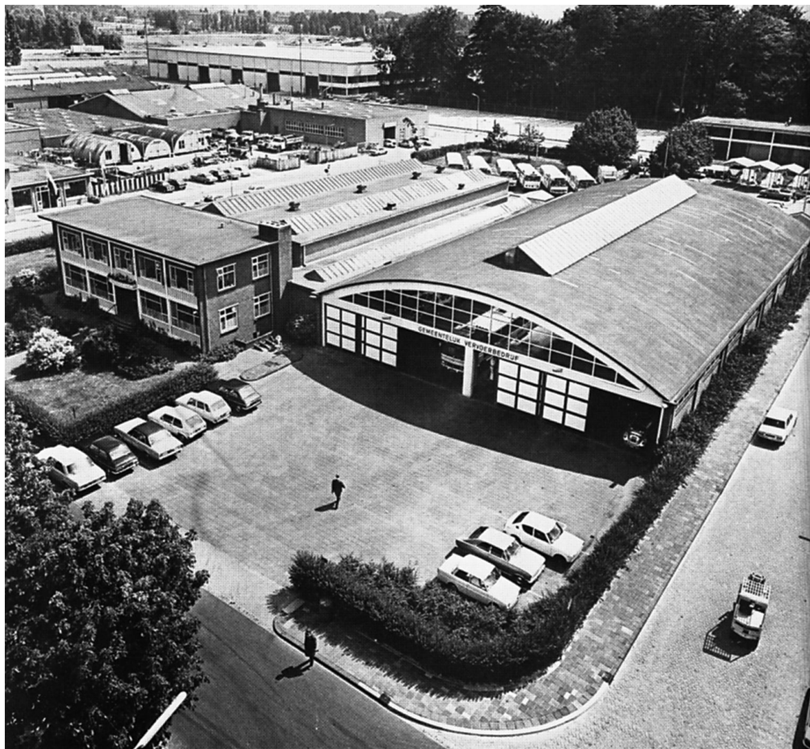
Afb. 5.1 Luchtfoto uit 1975 van het bedrijfscomplex van G.A.D./G.V.B. aan de Nijverheidstraat, (fotoarchief S.V.D.).
