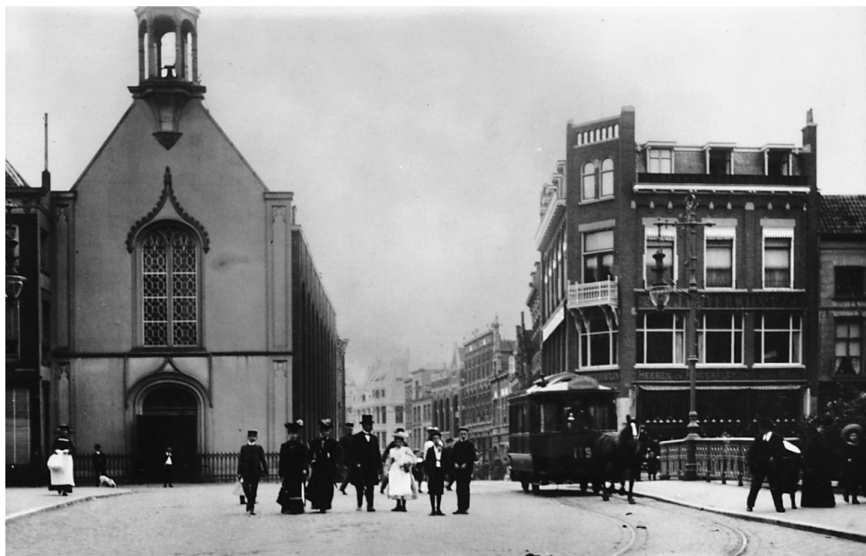
Afb. 2.11 Tramwagen 119 passeert in 1908 de in 1902 opnieuw verbrede Visbrug in de richting van de Groenmarkt, links de Waalse kerk, (foto S.A.D.).
