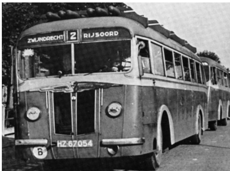
Afb. 4.31 Al snel na het begin van de Duitse bezetting gingen veel autobussen op gas rijden. Op de foto een Kromhout-bus met aanhanger van de R.A.G.O.M. met persgasflessen op het dak in 1940, (fotocollectie S.O. de Raadt).
