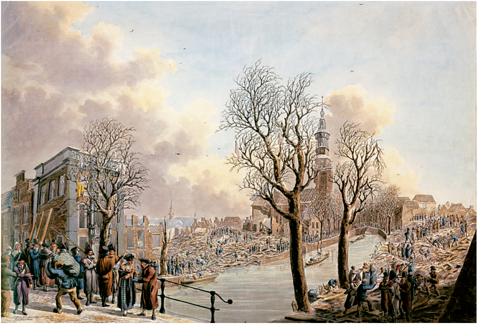
2.3 De ravage was groot na de ontploffing van een kruitschip in het Rapenburg te Leiden. Op 12 januari 1807 werd een groot aantal huizen verwoest (tekening door J. A. Langendijk).
