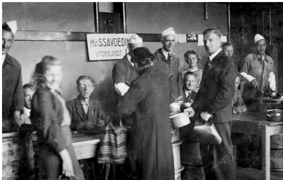
Afb. 10.9. De gaarkeuken aan het Mauveplein in 1945. Het was een van de uitdeelposten die door het gemeentebestuur waren ingesteld om 2/3 deel van de bevolking van enige voeding te voorzien (GAD 552-301.429).
