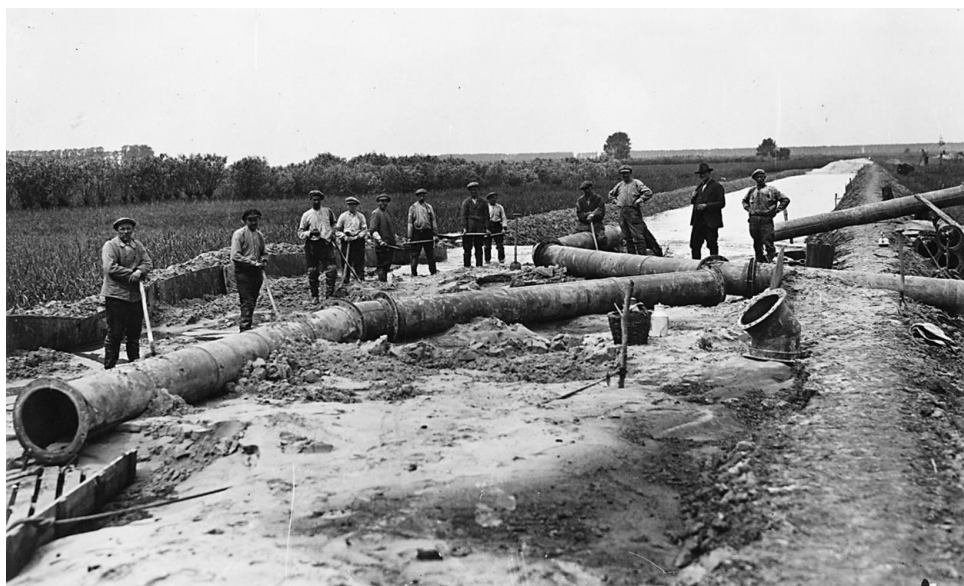
Afb. 1.7. Werklozen werden onder meer ingezet bij de inpoldering van de Dordtse Biesbosch. Hier poseert een aantal van hen bij de werkzaamheden in 1926 (GAD GPV M 10.894).
