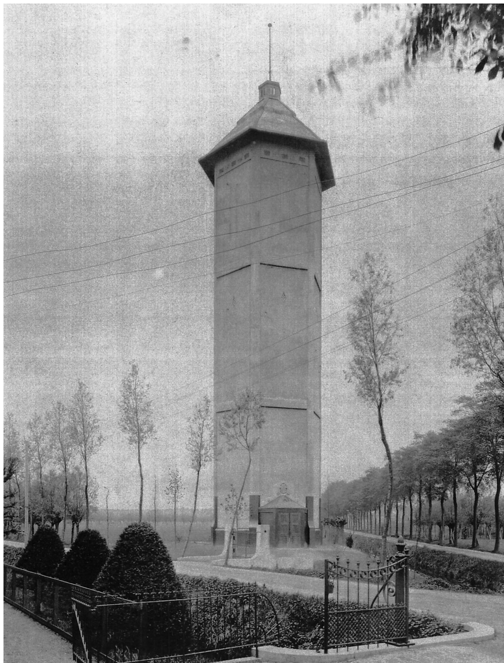
De Watertoren van Dubbeldam waarvoor Architectenbureau Visser & Smit uit Papendrecht in 1915 het onorthodoxe en gedurfde ontwerp leverde. De Provinciale weg heeft nog geen reconstructie ondergaan en de telefoonlijnen gaan nog via palen door het landschap, onder andere naar de 18 e -eeuwse boerderij op de voorgrond die na een grote brand in 1992 werd herbouwd (foto Stadsarchief Dordrecht).
