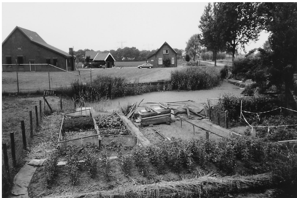
Het machinegebouw (met de gevelsteen 1916), de machinistwoning en het schuurtje staan er nog. Het machinegebouw / pompstation is weer ingeschakeld bij de waterwinning.
