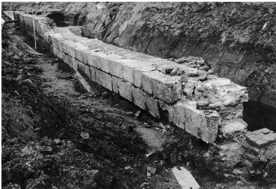
Afb. 21 Opgraving van een deel van de stadsmuur aan de Spuiboulevard (1998). Zichtbaar zijn de grote blokken kalksteen die in de 17e eeuw werden aangebracht om de muur meer luister bij te zetten. Foto: A. Molendijk, coll. DAC.
