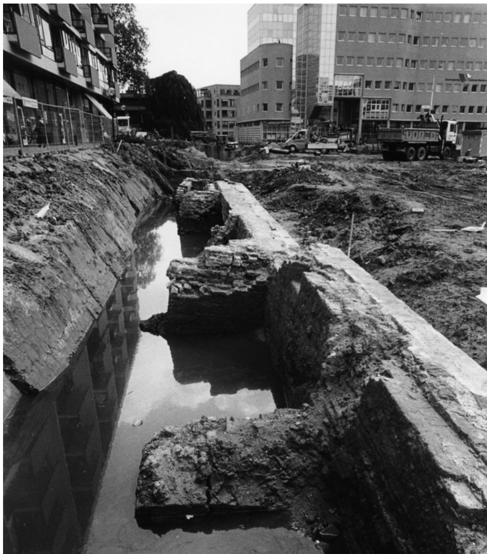
Afb. 55 Opgraving van de stadsmuur aan de Spuiboulevard nabij het Achterom. Duidelijk zichtbaar zijn de aanzetten van de bogen waarop de weergang aan de stadzijde rustte. Foto: A. Molendijk; coll. DAC.
